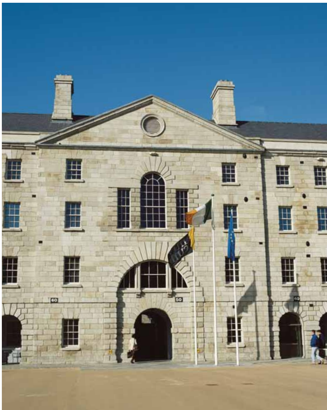
Vue de l'aile ouest du bâtiment de Clarke Square, montrant l'actuelle entrée des galeries d'exposition. Selon la tradition, le couloir et la fenêtre de la voûte auraient été construits pour que la reine Victoria puisse voir ses troupes tout en restant à l'intérieur
